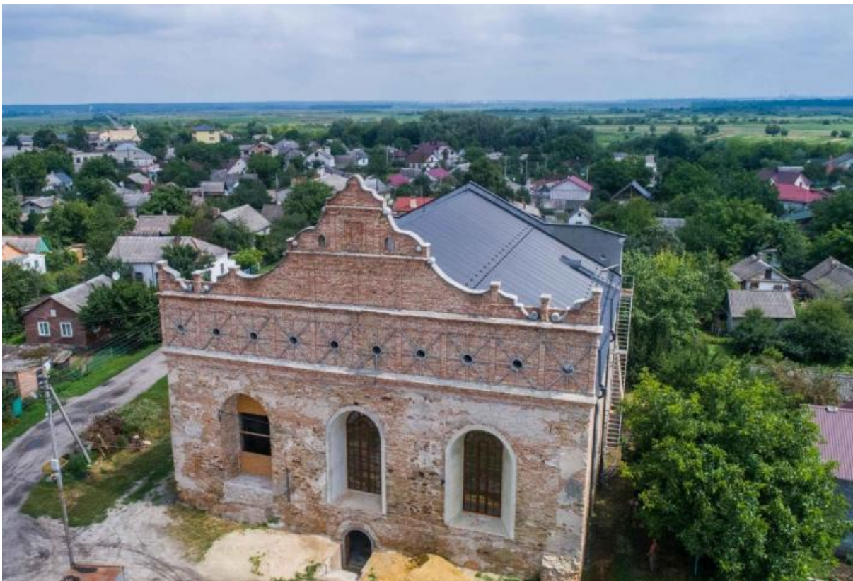
Синагога Острога в процессе реконструкции
